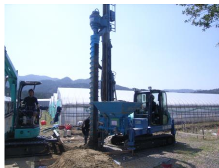
写真-1 エコジオ施工状況
