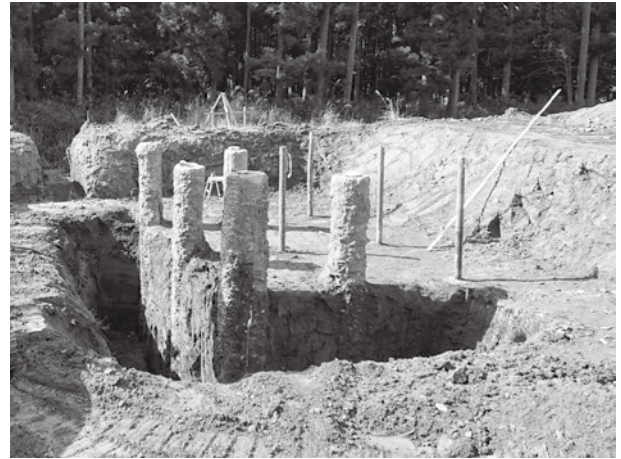
写真2 「セメントで固めた土」、「鋼管」を掘り出した様子
