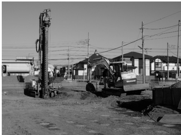
写真1 地盤改良工事の様子
