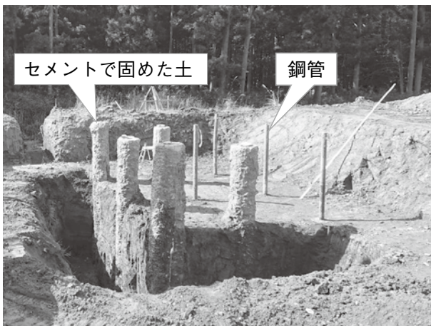
写真 セメントで固めた土、鋼管を掘り出した様子
