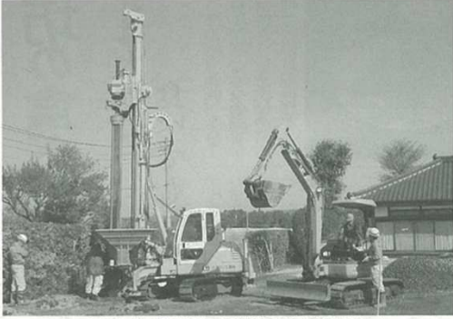
エコジオ工法による地盤改良の施工風景
