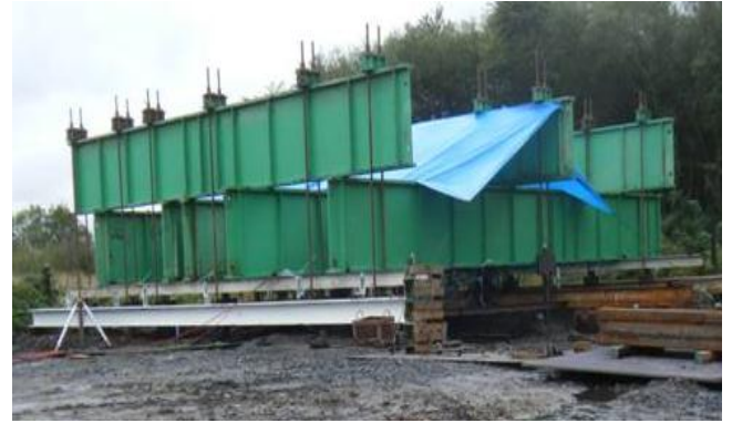
写真-1 平板載荷試験状況
