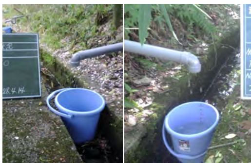
写真-5 p-2 の排水状況 (左:2016.4.14, 右:2018.9.5)
