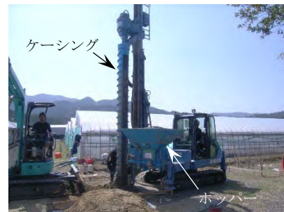
写真-1 小型地盤改良機を用いた施工状況
