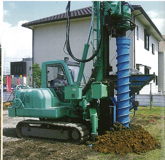
エコジオ工法施工時の様子
