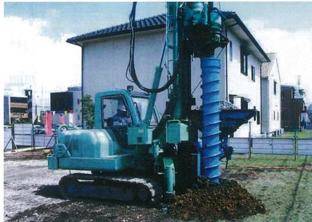
エコジオ工法の施工現場。「従来の地盤改良工事より浅い杭で同等の強さが期待できる」(エコジオ工法協会)という
