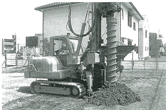
①標準工法では土砂を排出
