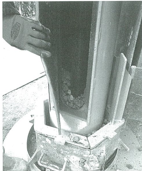
ケーシング側面から碎石を投入
