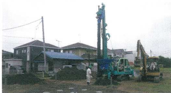
住宅用の地盤改良技術として普及しているエコジオ工法
