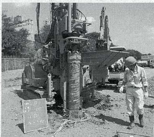
エコジオ工法で地盤を掘る
