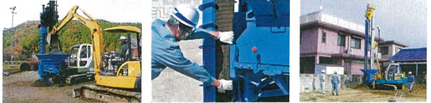
エコジオ工法による地盤改良作業の様子
