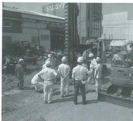
エコジオ工法地盤改良施工の現場
